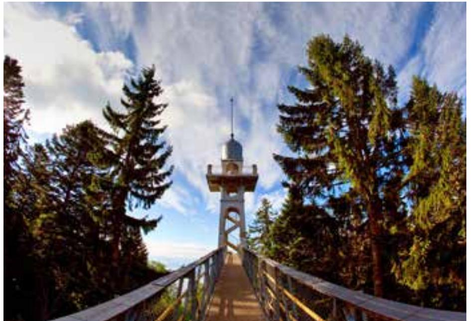
beton-Turm aus dem Jahr 1912 weist als Besonderheit auf, dass der Zugang zum Teil über eine lange schräge Rampe aus Stahl-fachwerkkonstruktion erfolgt. Über ein Drehkreuz mit nachfolgendem schrägen Steg zum Turm und 56 Treppenstufen erreicht man die Plattform in 10 m Höhe. Der Aussichtsturm mit Antenne ist etwa 20 m hoch.
